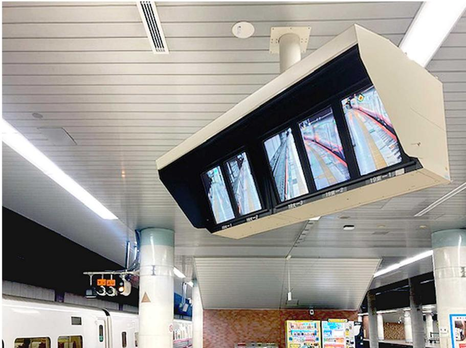
JR 東日本様では、1985年の東北新幹線上野駅-大宮駅間開業にあたり新設された4つのプラットフォームに、これまで画面比4:3の横型アナログ映像システムをご利用されておりました。今回の改良工事では、画面比9:16の縦型フルハイビジョン映像システムにすることで車両に沿った広い範囲の映像でお客様の乗降と安全運行を確認することができるようになりました。縦型とすることにより4連・5連などのモニター配列が容易となり、16両、17両の長い編成車両であっても1箇所ですべての映像を確認できます。高解像度のフルハイビジョンによる鮮明な映像で飛躍的に安全確認ができるようになった点は大きな改良点となります。また、昇降式ハウジングの採用により、スペースが限られるプラットフォーム上で脚立などを使用せずにメンテナンス作業を安全に実施することが可能になりました。少人数での作業によるメンテナンス作業の省力化や作業時間の短縮にもつながっています。
