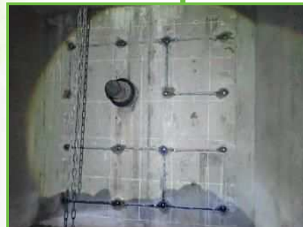
端部横桁にインサートタイプを設置します。桁内側から設置工事を行い遊間目地部鋼材の腐食を抑制します。
