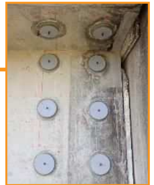
桁側面にサーフェスタップを設置します。桁端定着部の鋼材腐食を抑制します。
