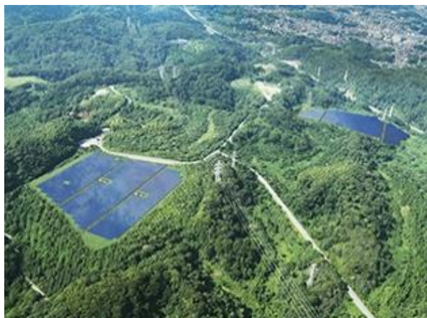
西武武山ソーラーパワーステーション
