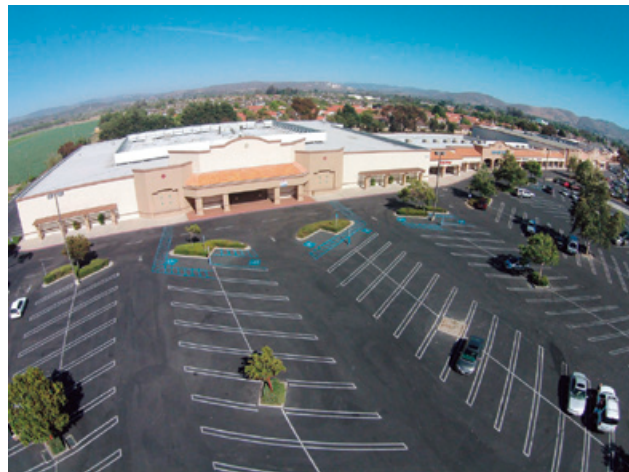
所在地：米国 カリフォルニア州 ロンボック市 敷地面積：230,432 sf (約6,452.09坪)
