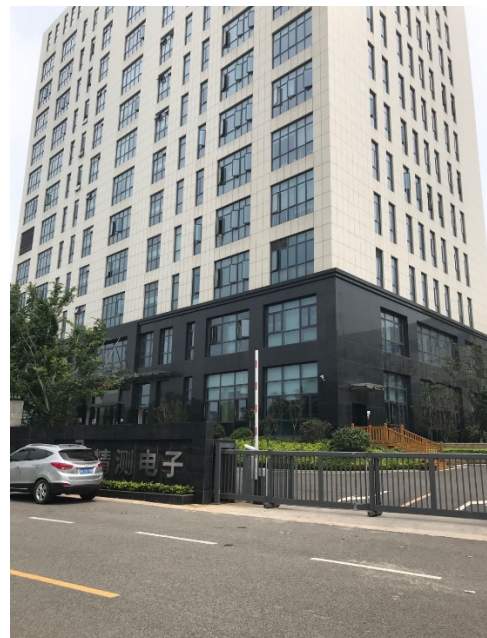
守衛所前からオフィス棟を撮影
