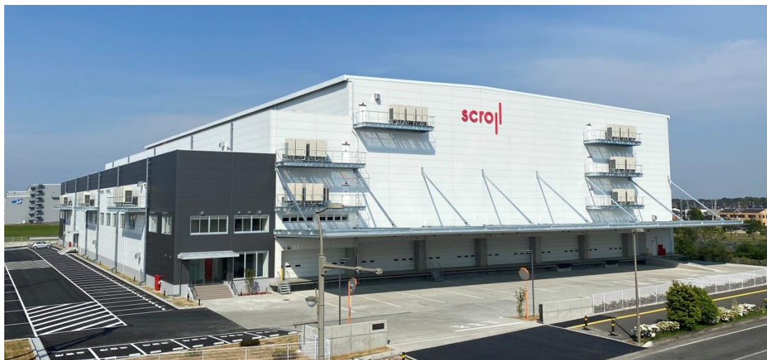
SLCみらい外観
