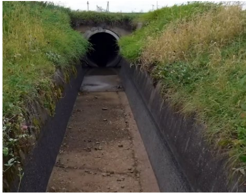
農業用排水施設
