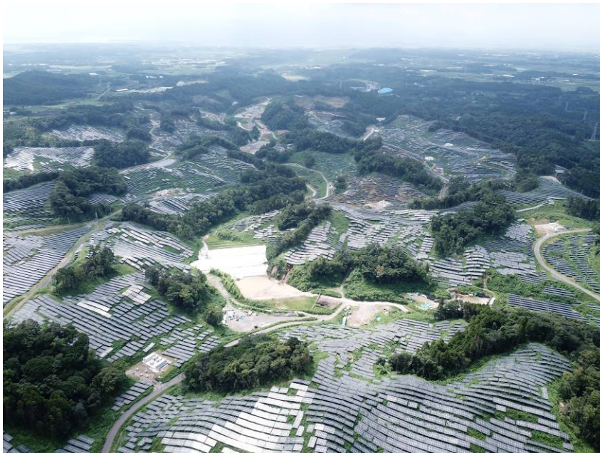
鹿屋大崎ソーラーヒルズ太陽光発電所
