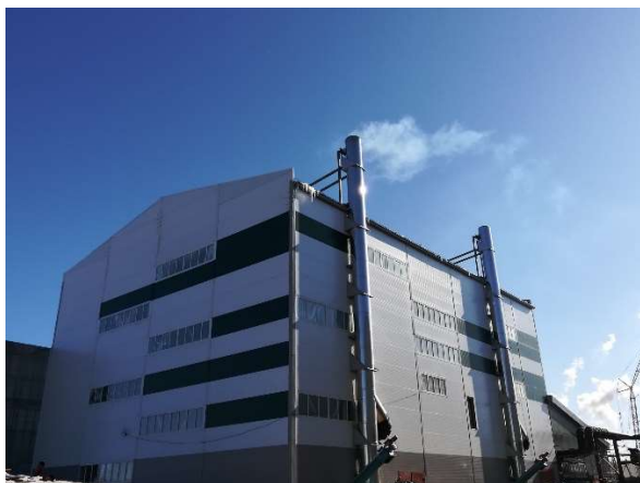
ボイラー工場
