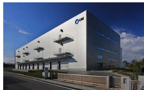
8 ロジスクエア新座 2017年4月竣工
