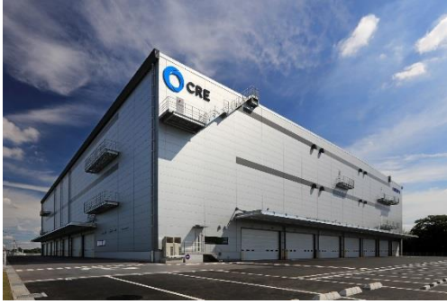
13 ロジスクエア春日部 2018年6月竣工
