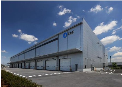
15 ロジスクエア川越Ⅱ 2019年6月竣工
