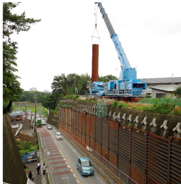
大口径杭（φ2000）による 道路拡幅工事（東京都）
