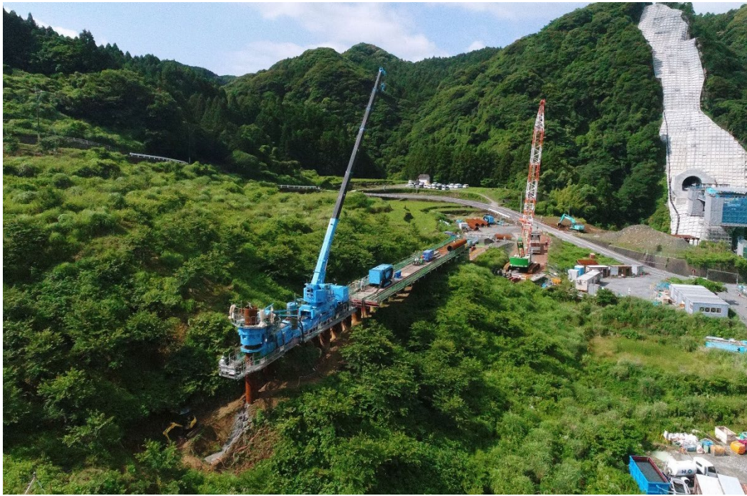
九州新幹線（西九州ルート）での地すべり対策工事（長崎県）
