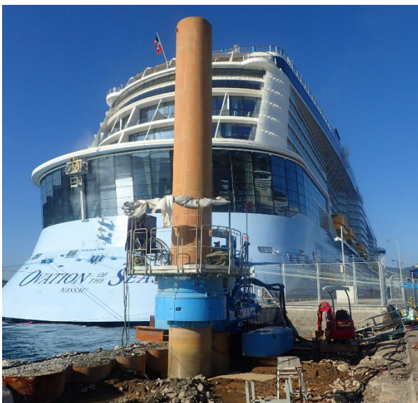
岸壁の改修・増深工事（長崎県）
