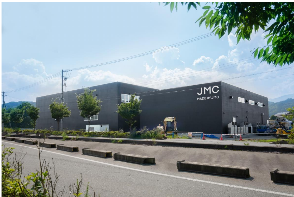
コンセプトセンター第5期棟（2018年1月稼働開始）および第6期棟
