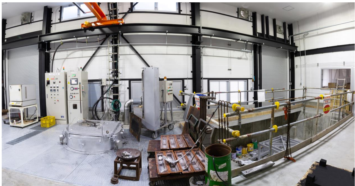
コンセプトセンター第6期棟 低圧鋳造室
