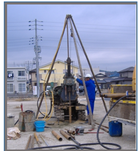
ボーリング調査による 「コア」採取の様子
