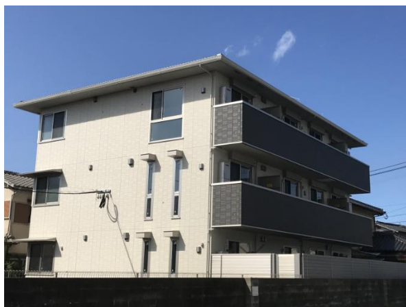
設置先： 福岡県の集合住宅 1列2段×2セット 大手ハウスメーカー施工
