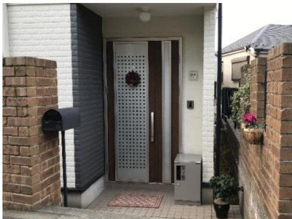
設置例： 横浜市の戸建て住宅 単独設置
