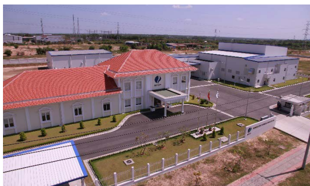
AFCP 社ロンタン工場（第二工場）外観
