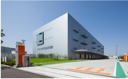
ロジスクエア草加 2013年6月竣工
