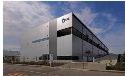
ロジスクエア久喜 2016年6月竣工
