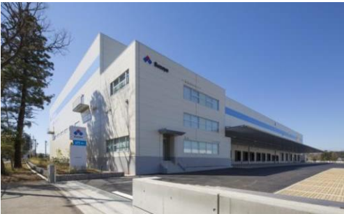
ロジスクエア日高 2015年3月竣工
