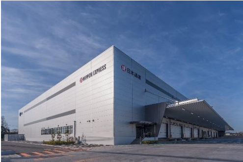
ロジスクエア鳥栖 2018年2月竣工
