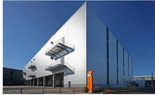
ロジスクエア八潮 2014年1月竣工
