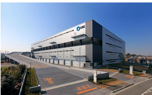
ロジスクエア浦和美園 2017年4月竣工
