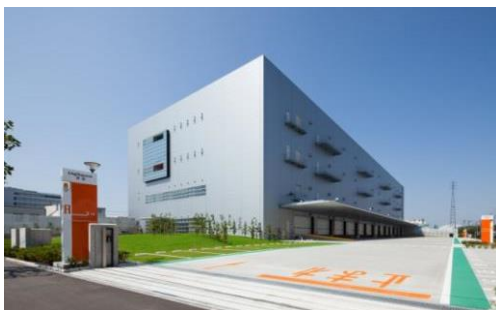
ロジスクエア草加 2013年6月竣工
