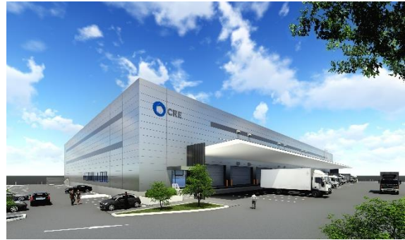
ロジスクエア鳥栖 2018年2月竣工予定
