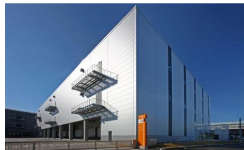
ロジスクエア八潮 2014年1月竣工
