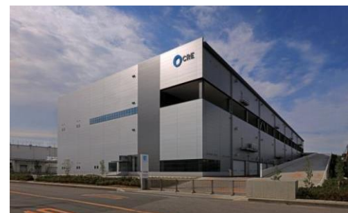
ロジスクエア久喜 2016年6月竣工
