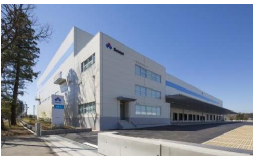
ロジスクエア日高 2015年3月竣工
