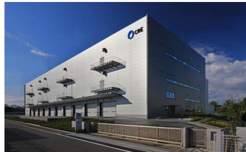
ロジスクエア新座 2017年4月竣工
