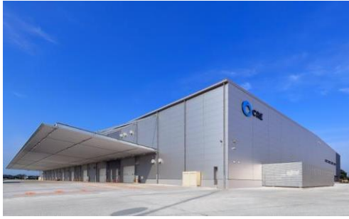
ロジスクエア羽生 2016年7月竣工
