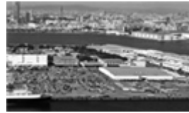
南港乗下船ヤード（土地）
