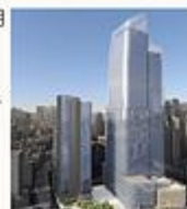
2017年4月 東京駅前 常盤橋 プロジェクト 着工
