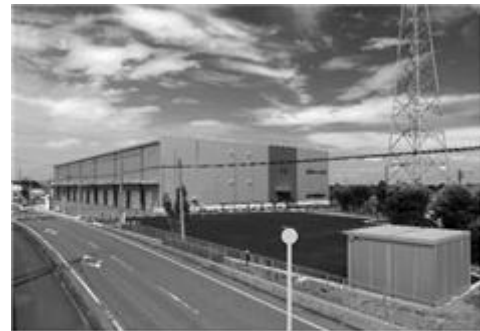
西側区画に駐車場 スペースを設置
