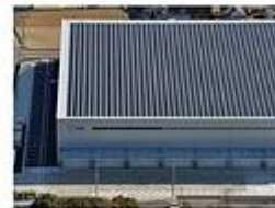
▶屋根全面に太陽光発電設備を設置
