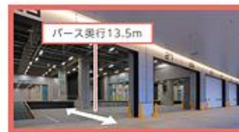
1・3階合計44台の大型トラックが同時接車可能
