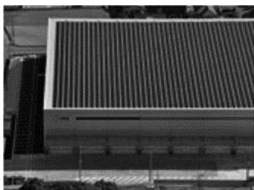
▶ 屋根全面に太陽光発電設備を設置
