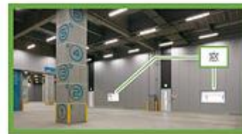
事務所と倉庫スペースの内壁に窓を設置することで、円滑な意思疎通が可能
