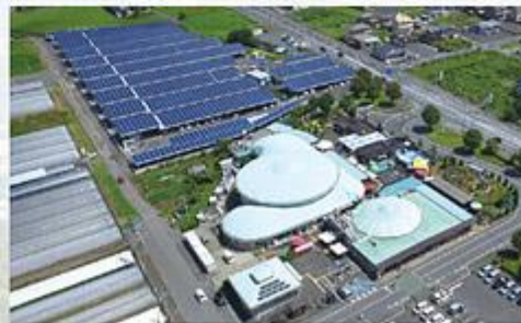
栃木県佐野市「道の駅 どんなんかたぬま」 パネル出力1.1MW 2016年8月竣工(注2)
