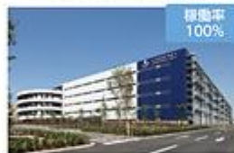
ロジポート川崎ベイ (296千㎡) 2019年竣工(共同開発)
