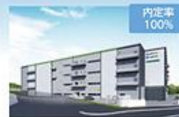
内定率 100% ロジスタ・ロジクロス茨木彩都(B棟) (31千m 2 ) 2021年竣工予定
