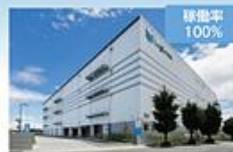
稼働率 100% ロジクロス厚木Ⅱ (35千m 2 ) 2019年竣工(単独開発)
