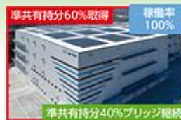
ロジクロス大阪 (36千㎡) 2018年竣工(共同開発)
