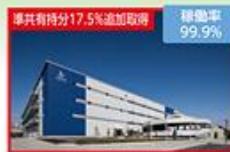
ロジポート大阪大正 (117千㎡) 2018年竣工(共同開発)
