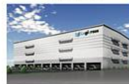
(仮称)ロジクロス船橋 (23千m 2 ) 2021年竣工予定
