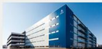
ロジポート橋本
