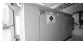
非常用発電機の設置
