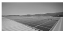
太陽光パネルの設置
