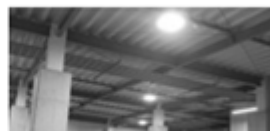
グリーンリース契約に基づくLED化改修
