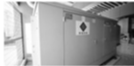
非常用発電機の設置
