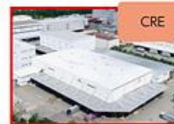
MJロジパーク西宮1(13千㎡) 1990年度竣工
