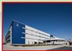
ロジポート大阪大正(117千㎡) 2017年度竣工(共同開発)
