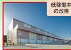
MJロジパーク春日井1(58千㎡) 2016年度竣工
