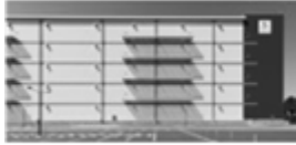
断熱サンドイッチパネルの採用
