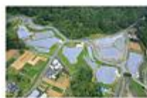
所在地:静岡県伊豆の国市 パネル容量:2.2MW
