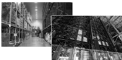
高度な物流機能に対応する 自動立体倉庫
