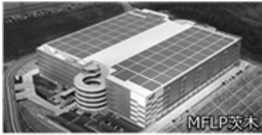
太陽光パネル
