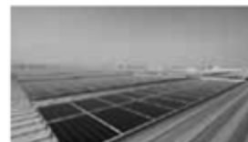
■ 太陽光パネルの設置
