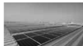
■ 太陽光パネルの設置
