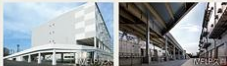
上層階(一部のフロア)へ直接アクセス可能なスロープ
