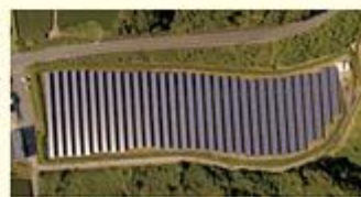
S-21 LS静岡御前崎発電所
