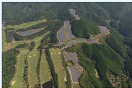
LS白浜発電所
