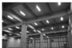
LED照明の導入
