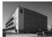
評価Sランク ★★★★★ ロジポート堺南島町
