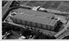
ロジポート流山B棟
