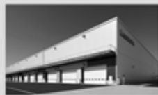
ロジポート堺築港新町
