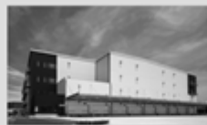
ロジポート柏沼南
