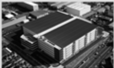
ロジポート橋本
