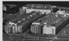
ロジポート東扇島 A棟、B棟、C棟
