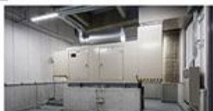
非常用発電機
