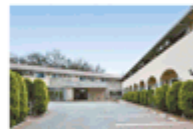
エクセレント西宮 (兵庫県西宮市)
