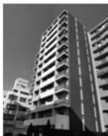
サムティ東別院RESIDENCE
