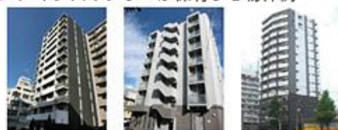
サムティ東別院RESIDENCE
