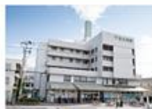
協立病院(兵庫県川西市)
