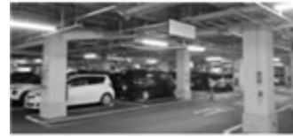
棟内駐車場 (地下1階、3階、屋上)
