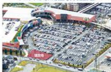
ユニクス伊奈の航空写真(建設地)
