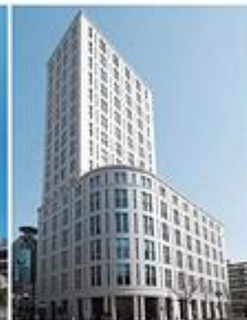
本町ガーデンシティ(オフィスビル部分) (注2)
