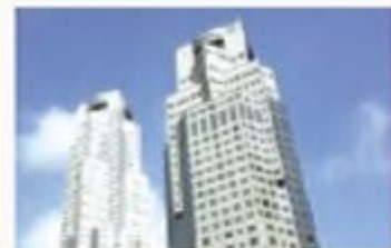
UOBグループが本拠を構えているビル
