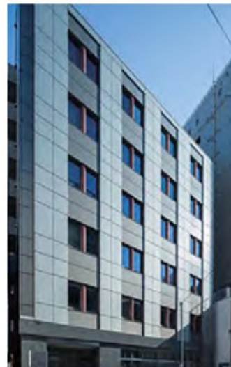
A-23 イトーピア岩本町ANNEXビル
