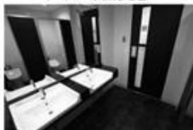
トイレ(改修後)
