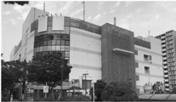
けみがわはま 検見川浜ベイサイドモールフェリア (仮称:イオンスタイル検見川浜)
