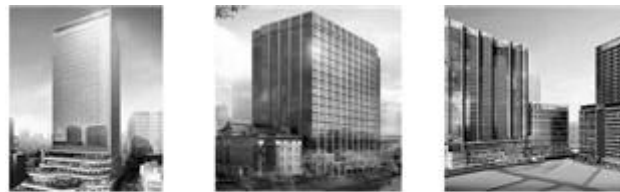
東京ポートシティ竹芝 2020年5月竣工 港区 オフィス/商業/住宅 延床面積：201千㎡
