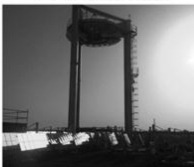
アラブの太陽熱発電の実証施設
