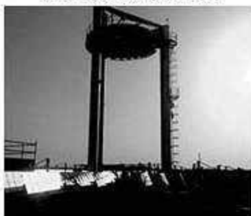
アブダビの太陽熱発電の実証施設
